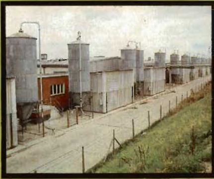
Ansicht einer Schweineproduktionsanlage. Links die Silos für Trockenfutter.
