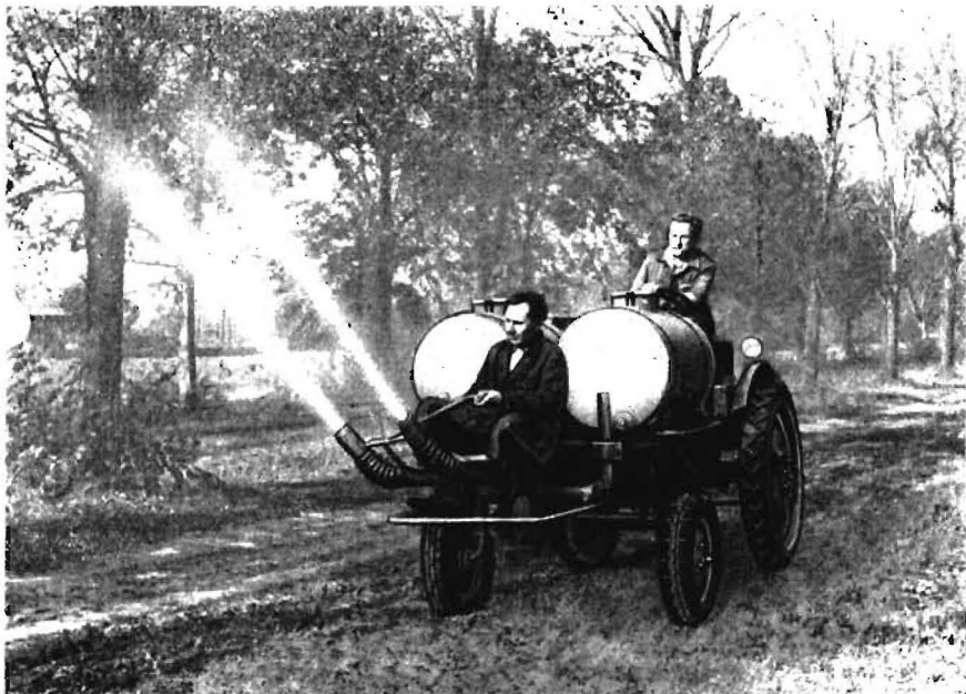
Abb. 44 Beim Sprühen von Bäumen mit Doppelbaumsprühdüse
